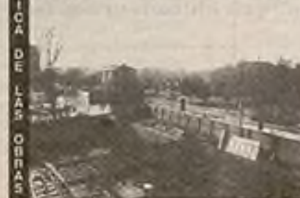
FOTO: Noviembre '95. Forjados en planta sótano.
