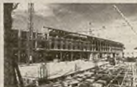
FOTO: Marzo '96. Avance de la fachada posterior a Cta. de Pastrana.
