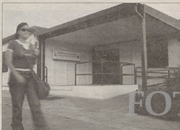
Las barracas serán sustituidas por un centro de salud fijo
