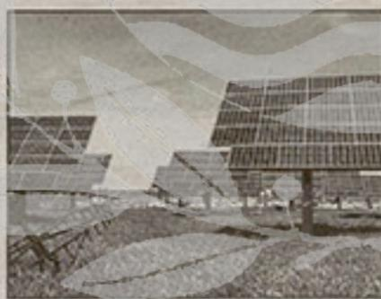
watios al año. Esta energía eléctrica procederá de la energía solar captada por los paneles, la cual se transformará en energía eléctrica continua y esta, a su vez, en energía alterna por medio de inversores situados en las mismas instalaciones deportivas. Una vez transformada la energía, ésta será inyectada a la red eléctrica de Iberdrola, lo que generará al Consistorio un ingreso de
