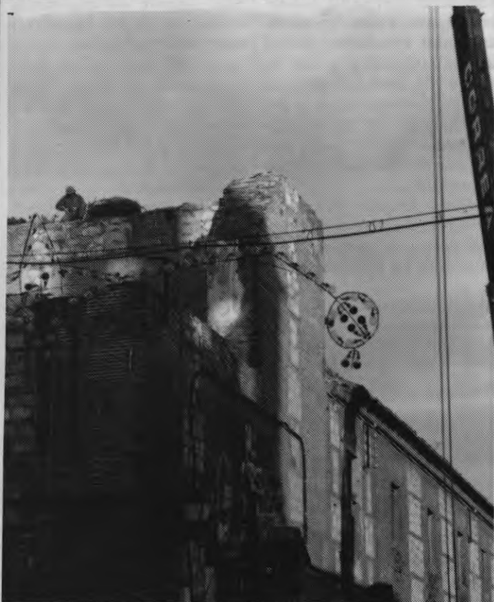
La operación requirió una grúa de grandes dimensiones
