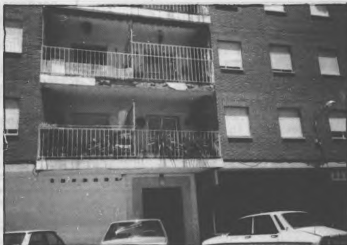
Portal de la vivienda de la calle Estocolmo, en la que se produjo la explosión.
