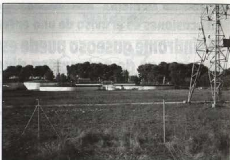
Depuradora de aguas residuales urbanas: necesita ampliación
