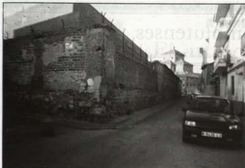
Muralla calle Portilla. Tapial restaurado con ladrillo.
