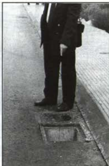
Una arqueta abierta en la que ya se ha producido algún accidente
