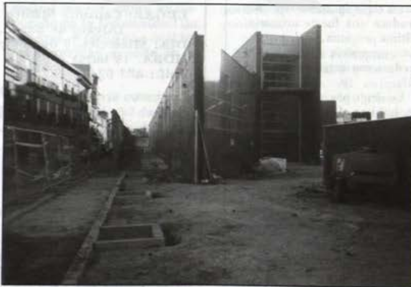
Biblioteca Central. Parte hecha con ladrillo visto.
