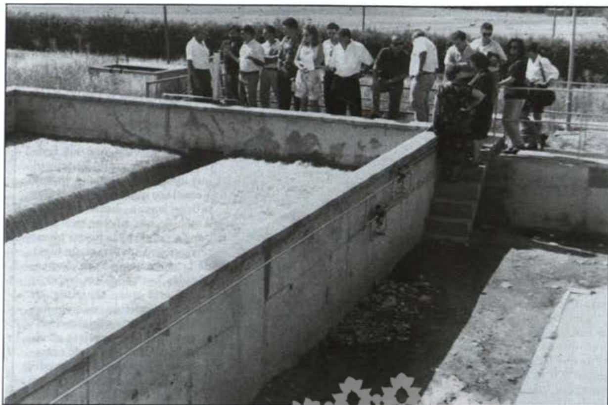
La segunda parte de la ampliación de la depuradora de Mohernando entró en servicio en julio de 1995.
