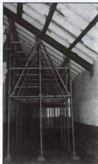
Detalle del apuntalamiento de un tendido.
