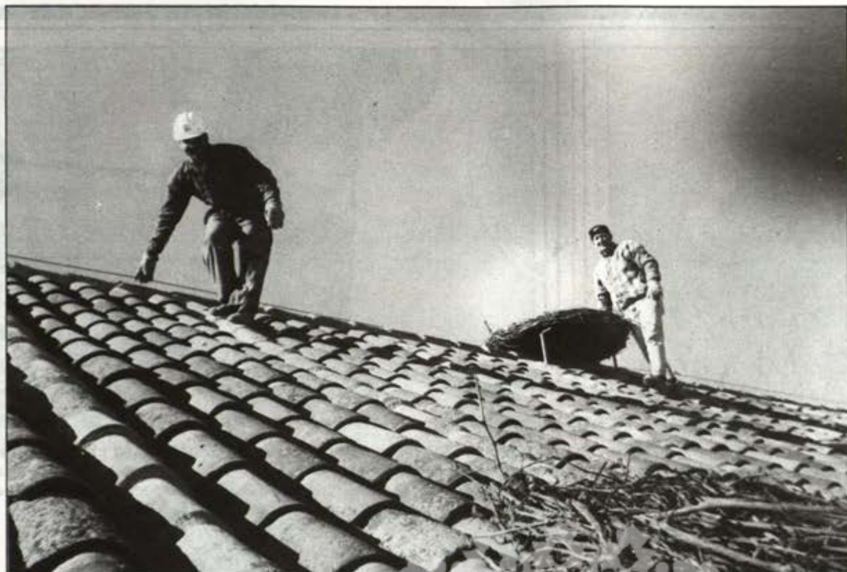
Colocación de nidos sobre el tejado de Caracciolos, después de su reparación.
