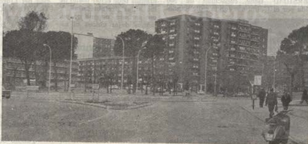
Un aspecto de la recién terminada raqueta de El Chorrillo, donde lucen ya los báculos de la moderna iluminación
