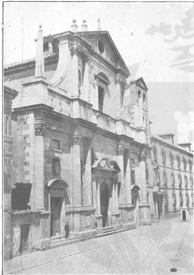
ALCALÁ.—FACHADA DE LA IGLESIA LLAMADA DE «JESUITAS» Y CUARTEL DE «MENDIGORRÍA» ALCALÁ.—FAÇADE DE L'ÉGLISE NOMMÉE «JESUITAS» ET CASERNE «MENDIGORRÍA»
