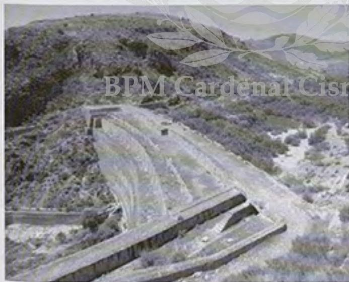
Figura 21. Embalse de Isabel II, en Almería, completamente inutilizado por acumulación de sedimentos. Atlas de Historia económica de Andalucía. SS. XIX y XX. Infraestructuras: Presas y Embalses. Figura 8, 1.
