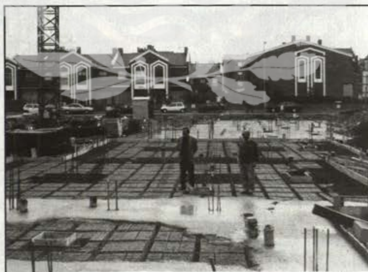
En las imágenes, dos aspectos del inicio de los cimientos para levantamiento de estructuras de la última fase de chalets.
