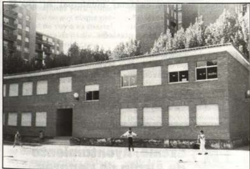
El edificio de la escuela infantil es independiente del edificio central del colegio Henares, sus construcciones son distintas.
