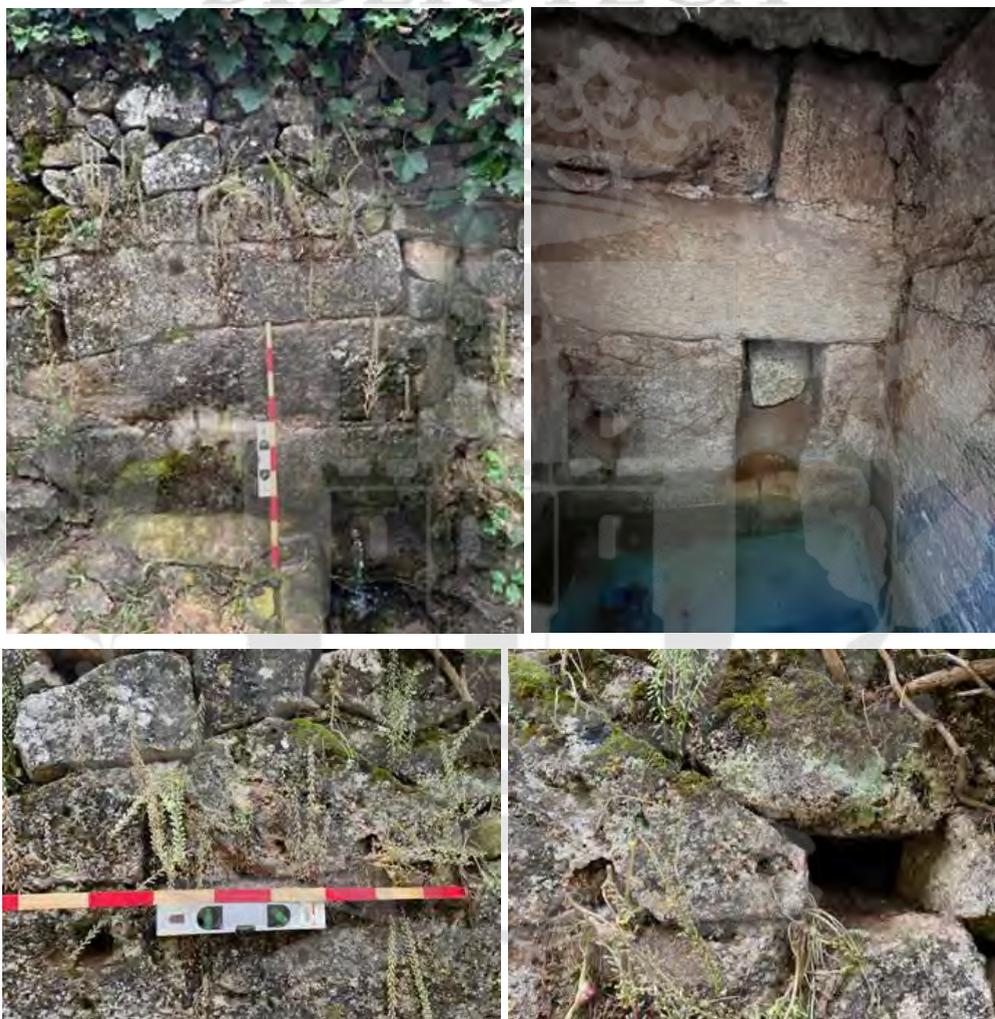
Fig. 6. a y b. Arriba, vista exterior e interior del frontal de la fuente de Abajo, indicándose el previsible apoyo de la bóveda en el paramento exterior. Abajo, dos detalles del acabado triangular del frontal Imagen propia.
