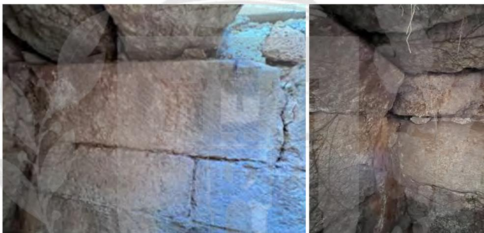
Fig. 7a. A la izquierda, detalle del paramento interior de la estructura abovedada de la fuente de Abajo de Santamera y lajas del posible tejado a dos aguas. Fig. 7b. A la derecha, punto donde se observa el arranque de la bóveda. Imagen propia.
