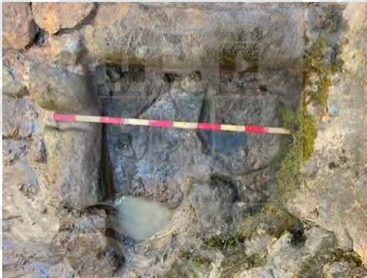
Fig. 4. Detalle del pocillo n° 1 de la fuente de Abajo de Santamera, que permite observar las características del fondo empedrado y la brecha en el nivel de greda en el nivel de agua. Imagen propia.
