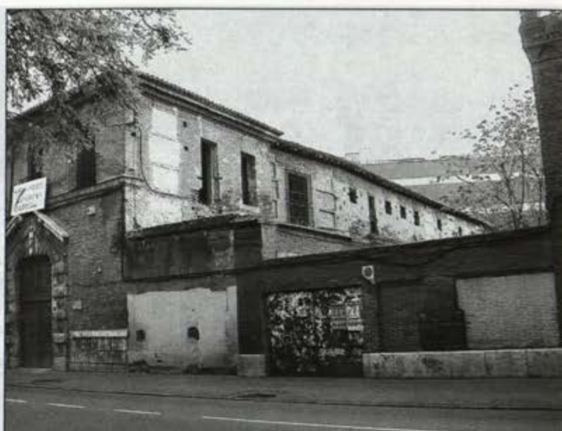
El colegio de los Basilio necesita aún mucha restauración.
