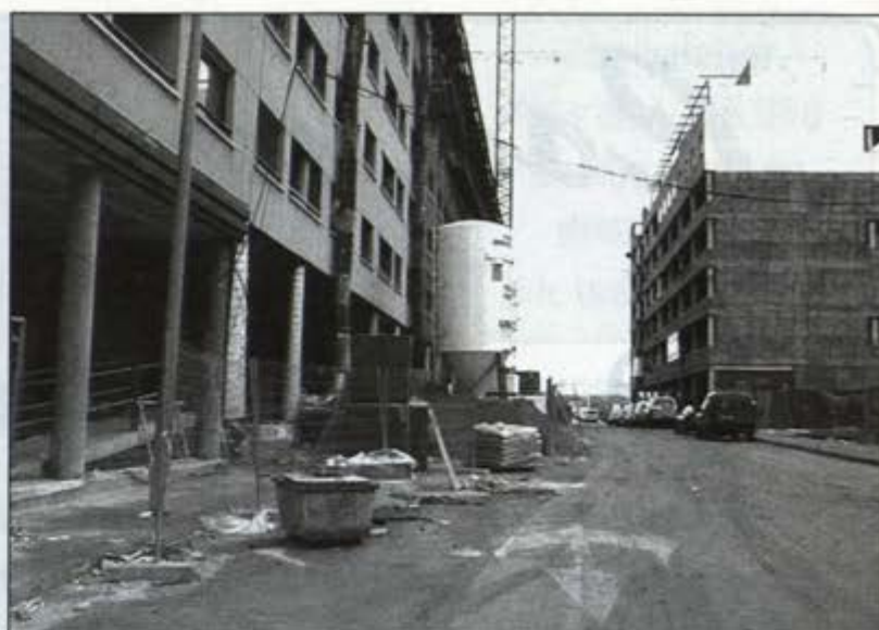
Las calles cercanas a Jorge Luis Borges muestran el aspecto que se ve en la fotografía a causa de las obras.
