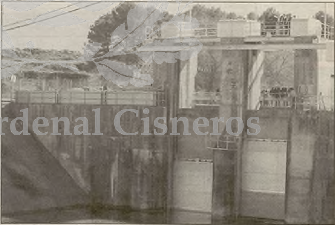
Compuerta que comunica los pantanos de Entrepeñas y Buendía.
