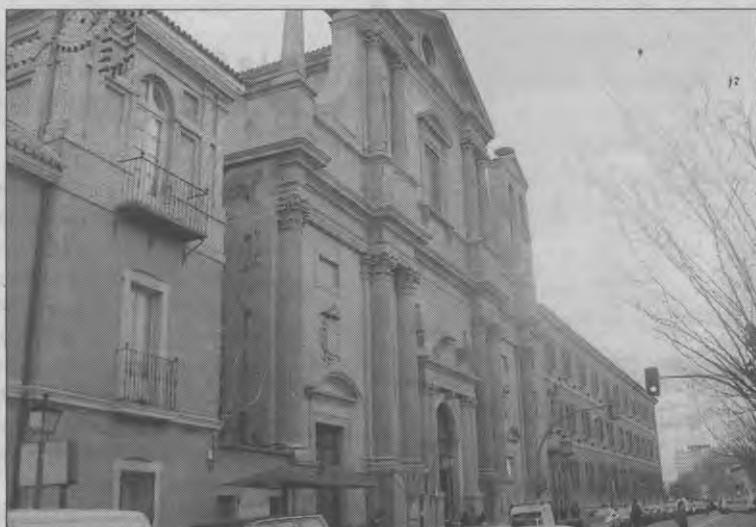
Aspecto de la fachada de la iglesia.
