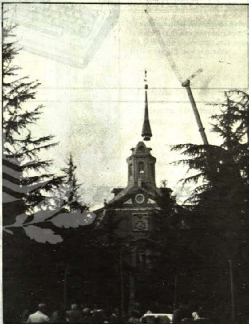
Lo más espectacular de la obra de las Bernardas fue el remate de la torre. En nuestra foto, la colocación del chapitel, con el auxilio de una grúa de más de sesenta metros. La operación, que duró poco más de media hora, suscitó la curiosidad de muchos alcalaínos que estaban por la zona.
