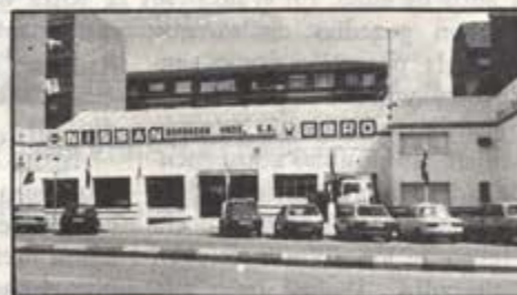
Fachada instalaciones Barragán Hnos. en Torrejón de Ardoz
