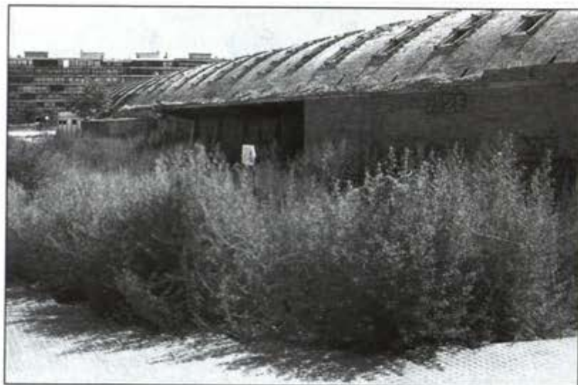
La antigua fábrica de Forjas genera problemas de droga.
