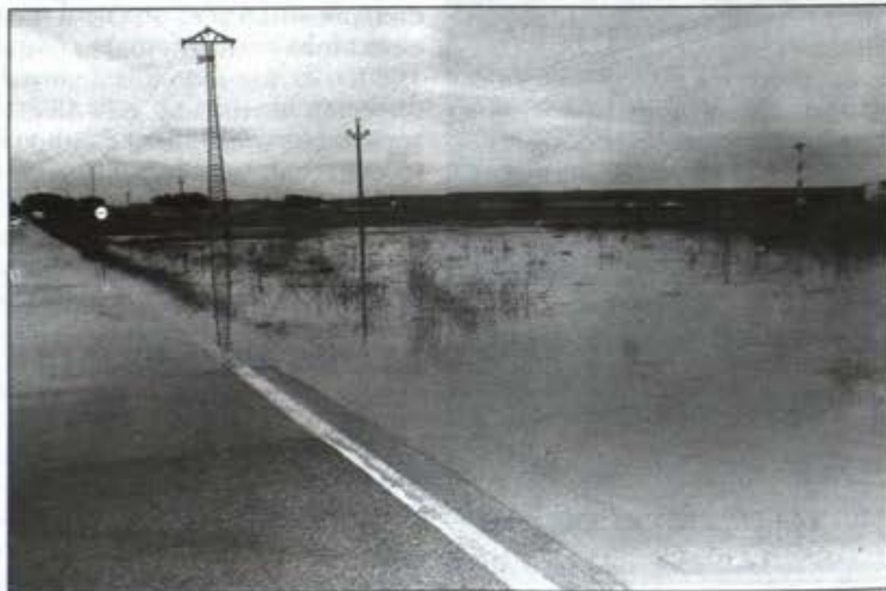
La carretera de Daganzo quedó completamente anegada.
