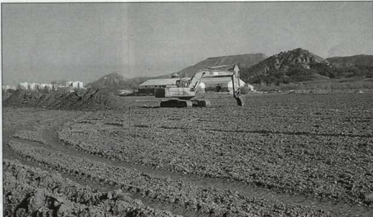
La denuncia contra la construcción de un ferial en la Isla del Colegio ha sido rechazada. Las obras continuarán.
