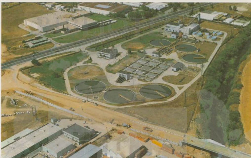
La depuradora de residuos industriales recibe la red de colectores de la cuenca industrial conectada a las empresas.
