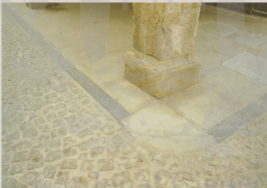
Detalle del encuentro entre pavimentación calzada y acera. Para esta última se utilizaron grandes losas de piedra granítica.
