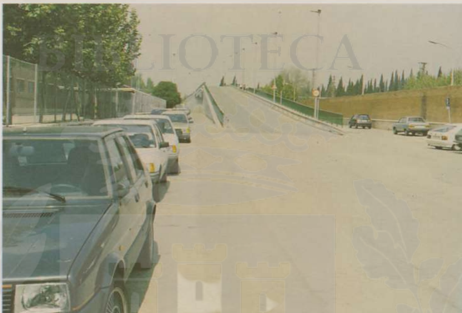
Puente sobre la vía férrea a la altura de Roca. Con su construcción se ha logrado desviar el tráfico hacia la Ctra. de Daganzo.
