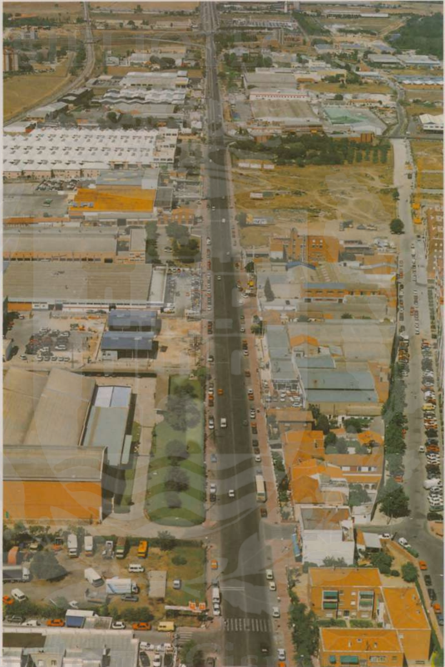
Vía Complutense hasta su salida a la N-II. Se han realizado aceras en ambos lados de la calzada y dotado de iluminación a todo el tramo.
