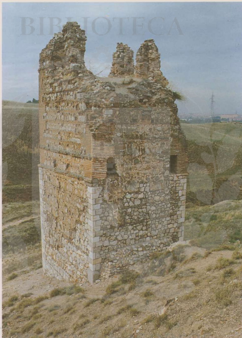
Torre albarrana, reconstruida a instancias del arzobispo Tenorio en el siglo XIV, fue consolidada en 1985.
