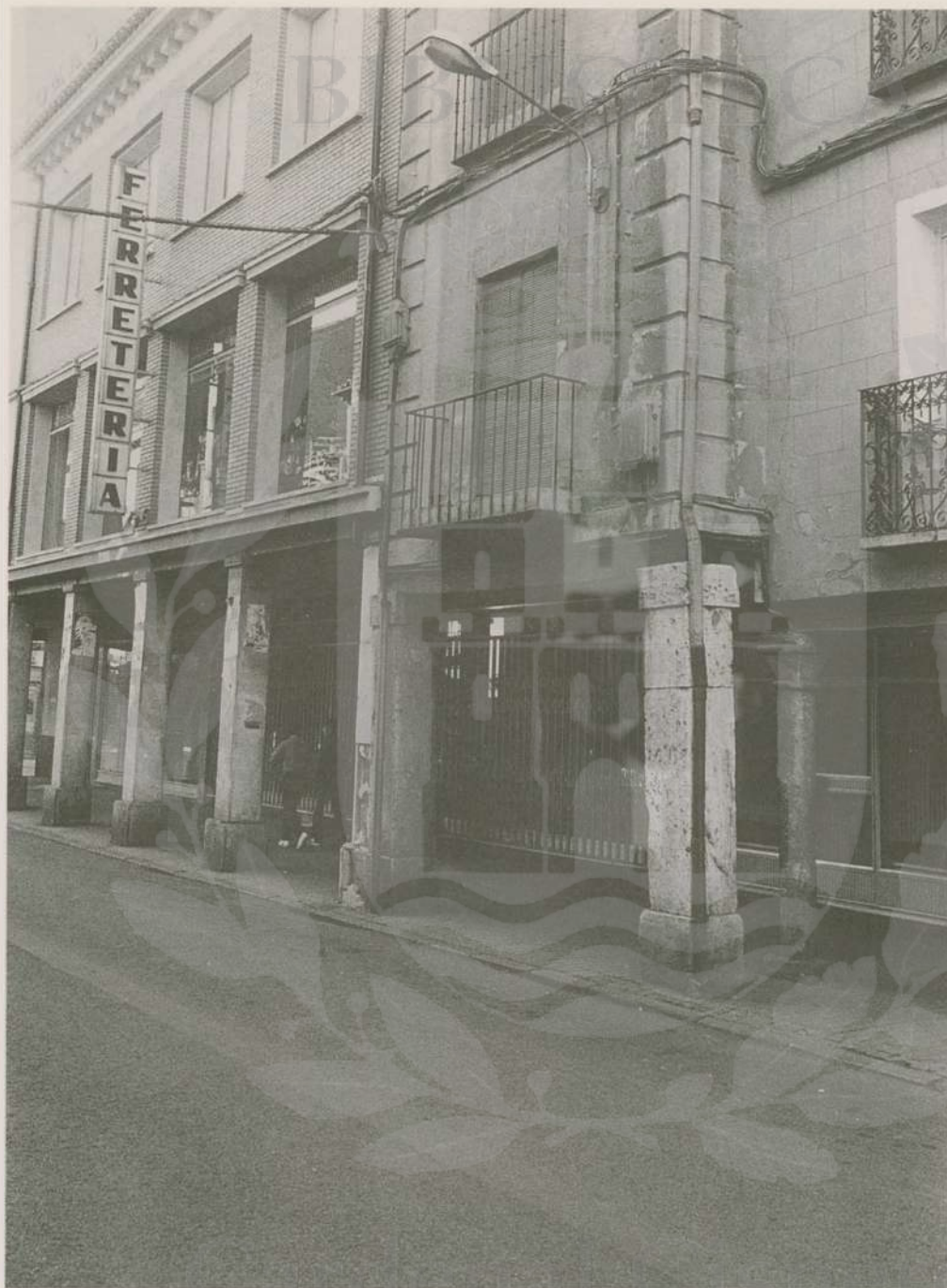
La calle Mayor, debido al deterioro sufrido por el paso del tiempo y el intenso tráfico soportado, había quedado degradada y perdida su funcionalidad.
