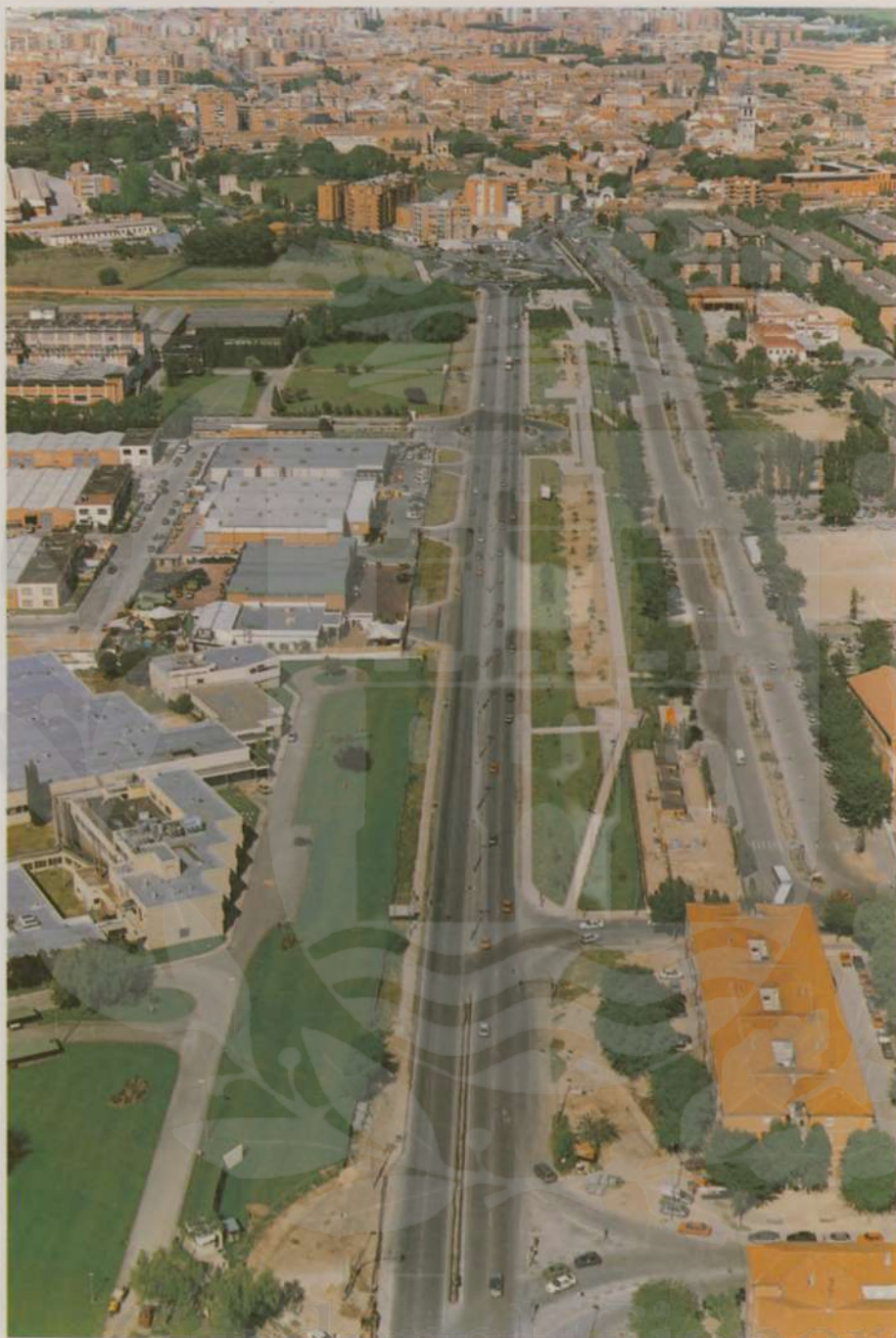
Entrada a Alcalá desde Madrid. Vista desde Liade hasta la gasolinera de la Puerta de Madrid. Se ha creado un parque lineal de más de 600 m. de longitud y 50 m. de anchura.
