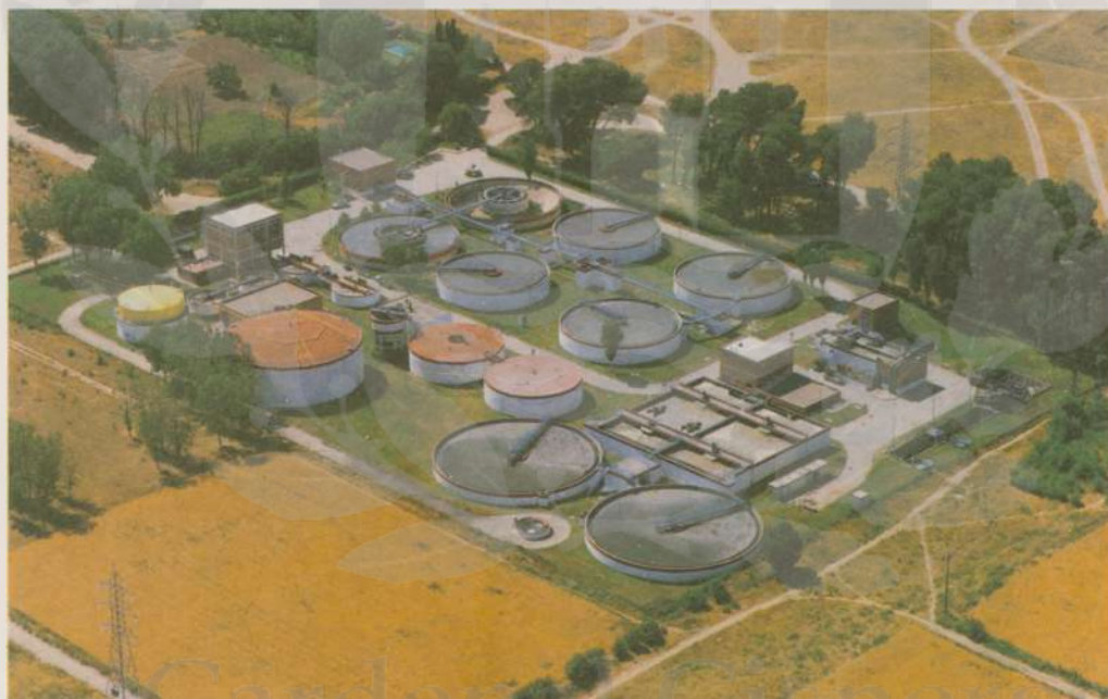
La depuradora de aguas urbanas recibe los vertidos a través de la red de colectores de la cuenca urbana.
