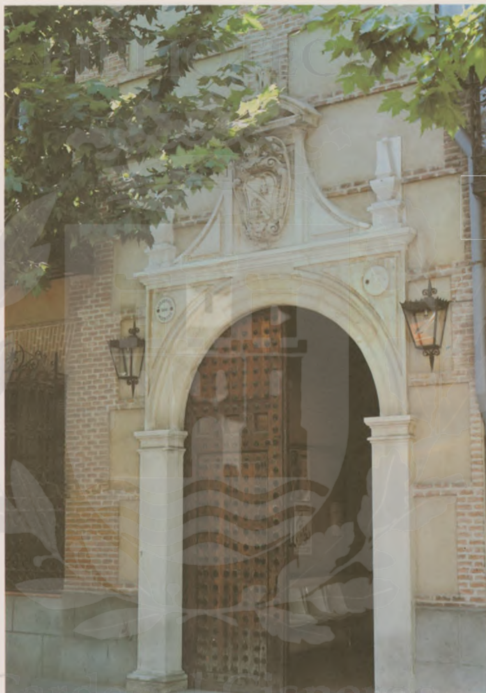
Portada Centro Salud rehabilitada.
