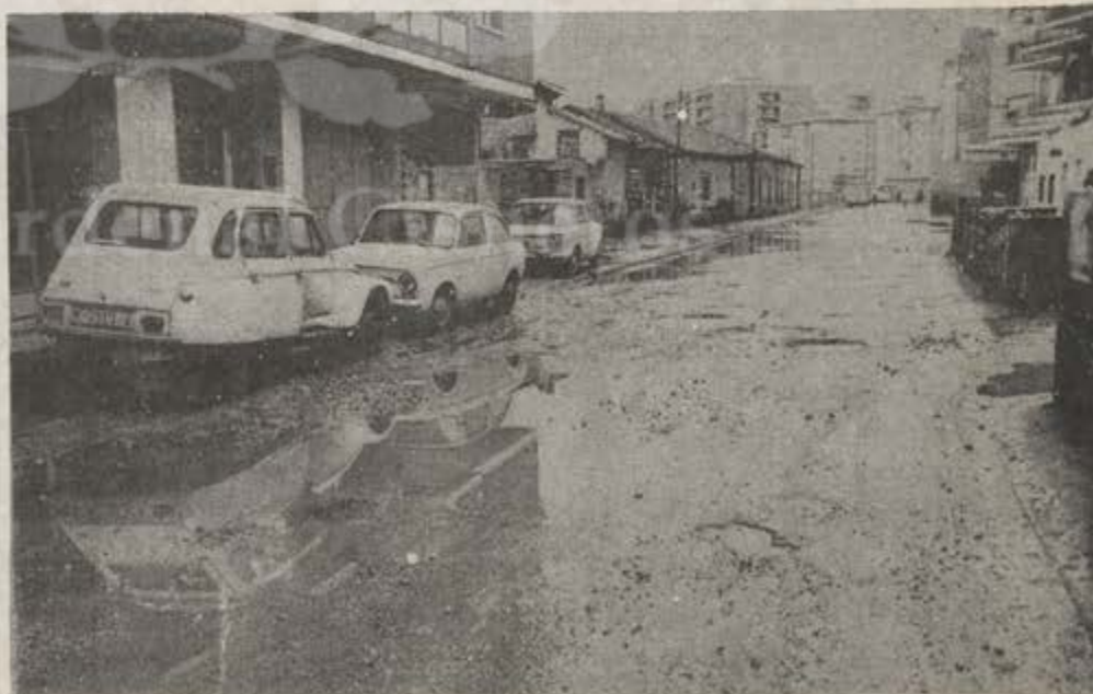
Se adjudicaron las obras para el arreglo de la calle de la Era Honda por un importe de casi cuatro millones de pesetas
