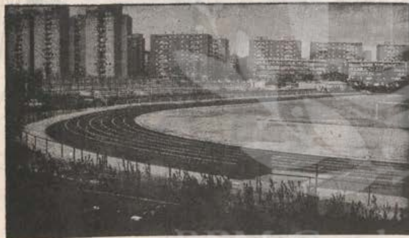
Un detalle, con uno de los campos de fútbol y las pistas de atletismo. Las edificaciones del paseo del Val, al fondo.
