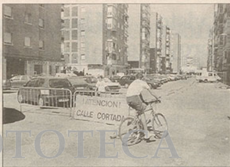
Esta será la señal que se instale antes del asfaltado / D.C.
