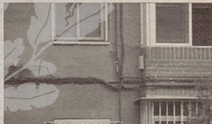
El ladrón accedía por las tuberías del gas
