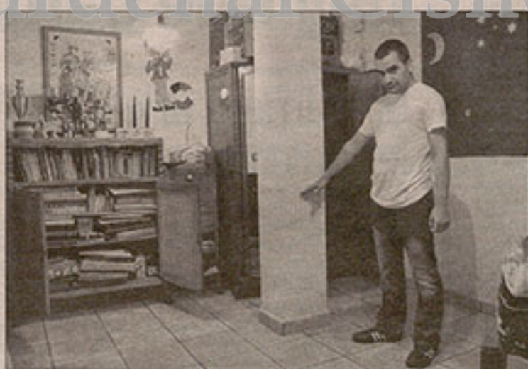
UNA 'PISCINA'. Las salas del garaje quedaron anegadas por la lluvia
