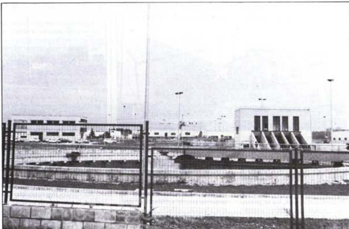
Con una inversión total de 1.500 millones de pesetas, se terminó, a mediados del año pasado, una nueva estación depuradora para las aguas residuales de Alcalá. Esta planta, que tiene una capacidad total de depuración diaria de 56.000 metros cúbicos de agua, no trabaja actualmente al 100% de sus posibilidades, siendo la cantidad de agua que recibe de 35.000 metros cúbicos, es decir, alrededor de un 63%.
