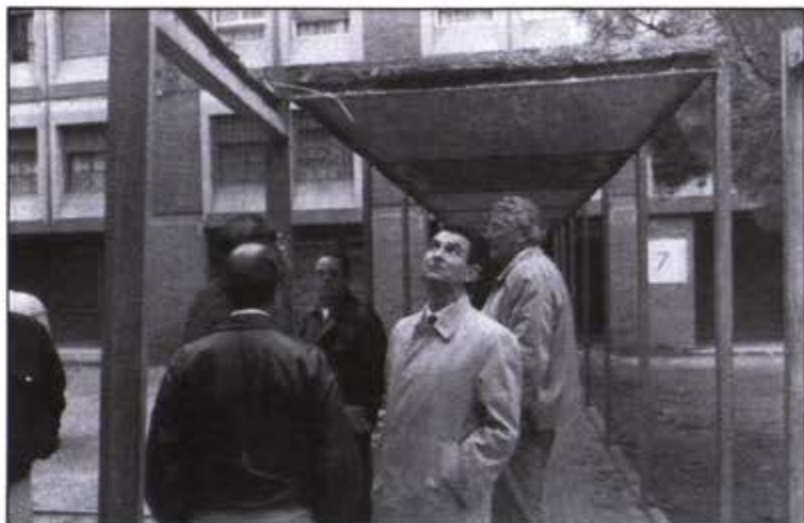
El alcalde comprobó el desmantelamiento de los voladizos de Santa Mónica en su visita de la mañana.
