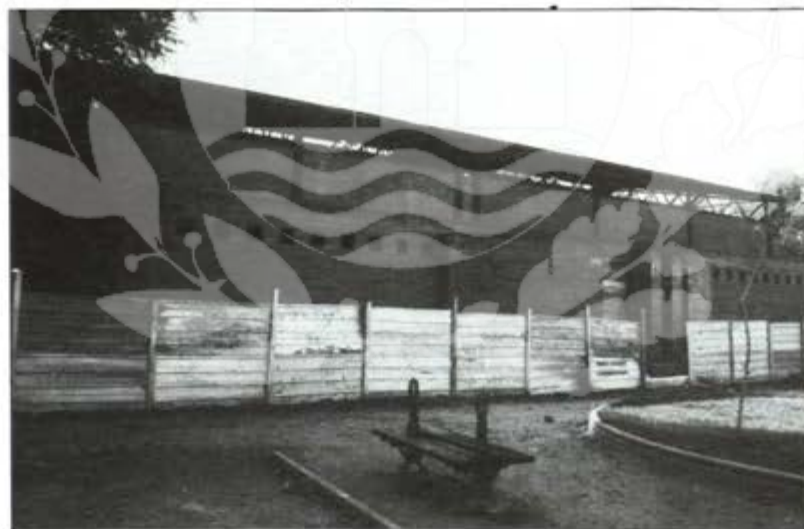
El pabellón polideportivo tiene paralizadas las obras.
