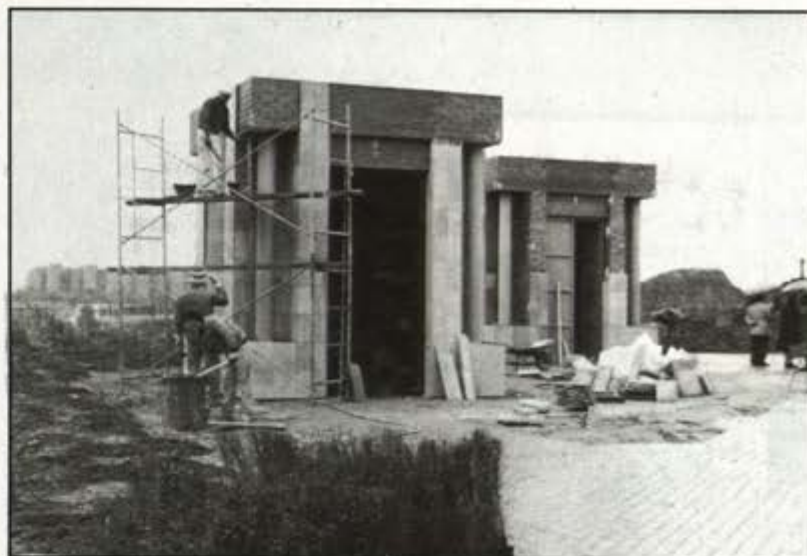
Los dos panteones en fase avanzada de construcción
