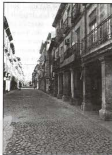
A la calle Mayor, además de nueva pavimentación, se la hicieron nuevas canalizaciones de saneamiento, alumbrado y telefonía.
