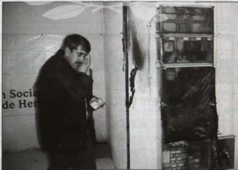
El entonces todavía concejal de Seguridad, Julián González del Cerro, examina los desperfectos producidos por el fuego.
