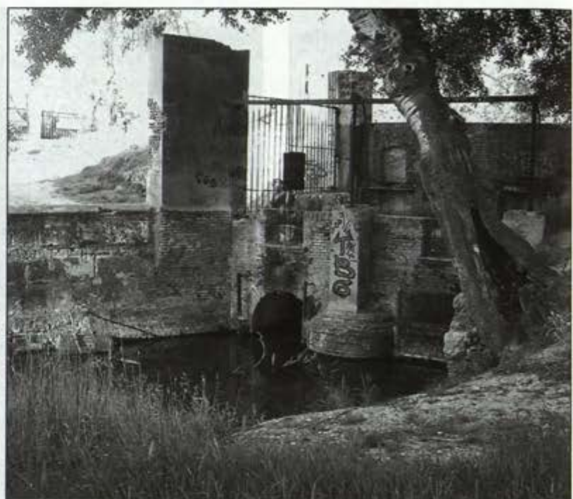
Arranque del caz construido para llevar el agua al molino.
