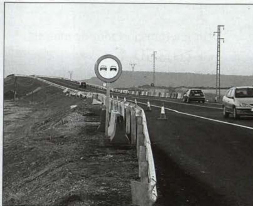
El puente de reciente construcción sobre la R-2
