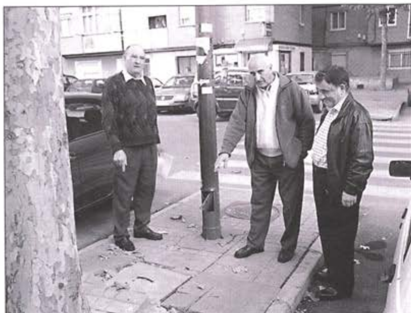
Mariano Refigio, Demetrio Gilsanz y Salvador Guardiola muestran el árbol que ha levantado la acera y que temen que rompa la tubería de gas que pasa por debajo
