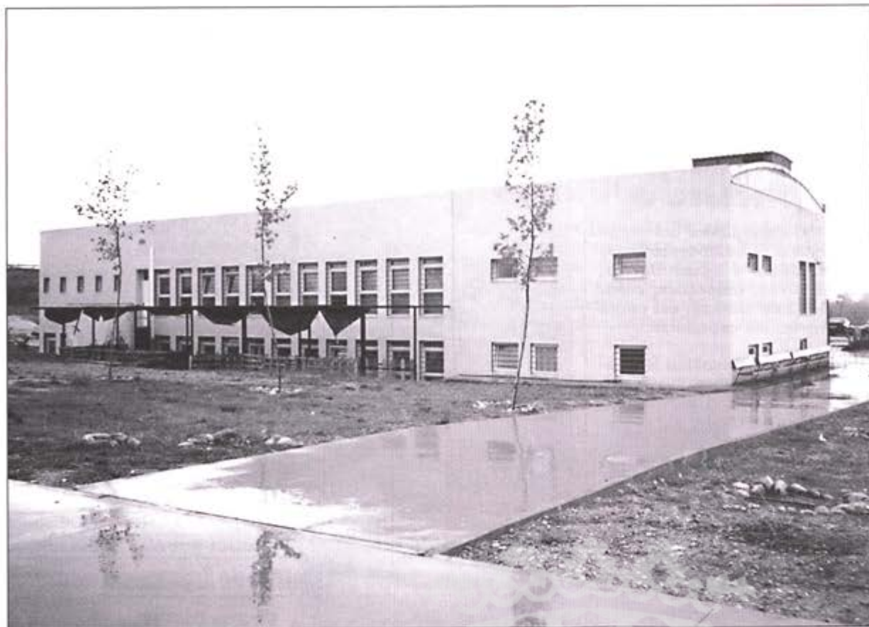
Centro ocupacional, en el camino de Camarma, que el ayuntamiento tiene cedido a APHISA
