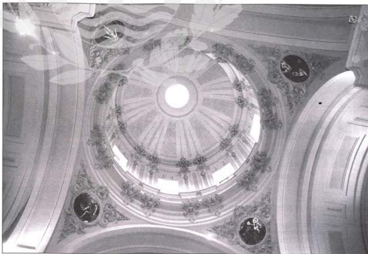
La cúpula vista desde el interior del templo restaurado.
