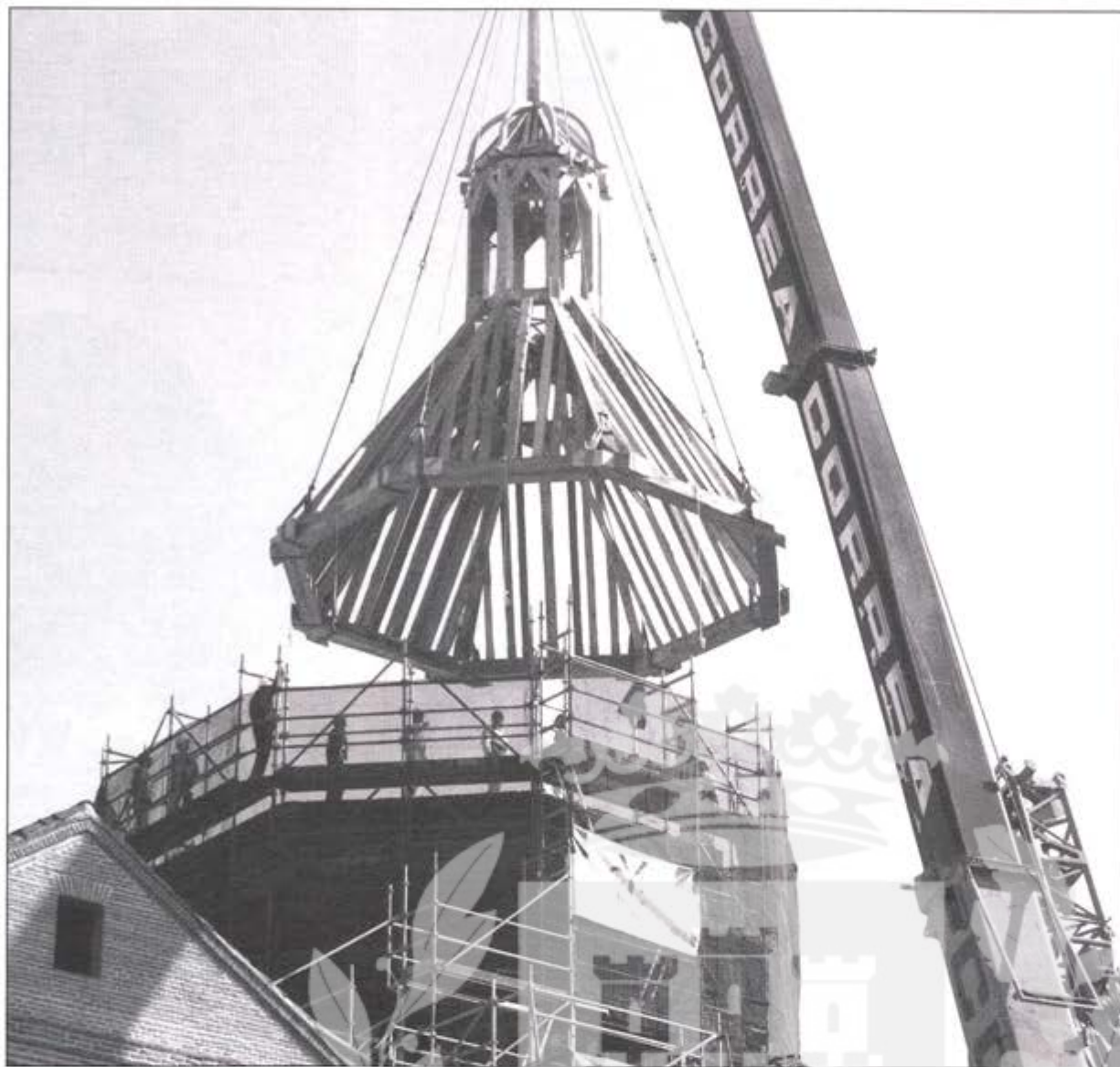
En estas fotos del archivo de PUERTA DE MADRID, colocación de la estructura de madera que sirve de almacén a la cúpula y de la veleta y cruz que rematan el conjunto rehabilitado.
