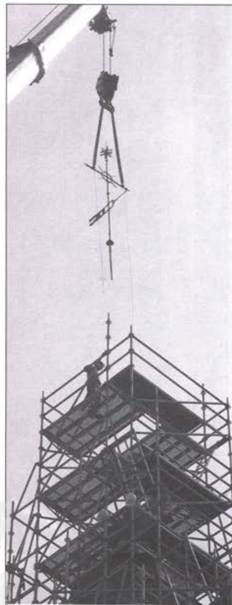
En estas fotos del archivo de PUERTA DE MADRID, colocación de la estructura de madera que sirve de almacén a la cúpula y de la veleta y cruz que rematan el conjunto rehabilitado.
