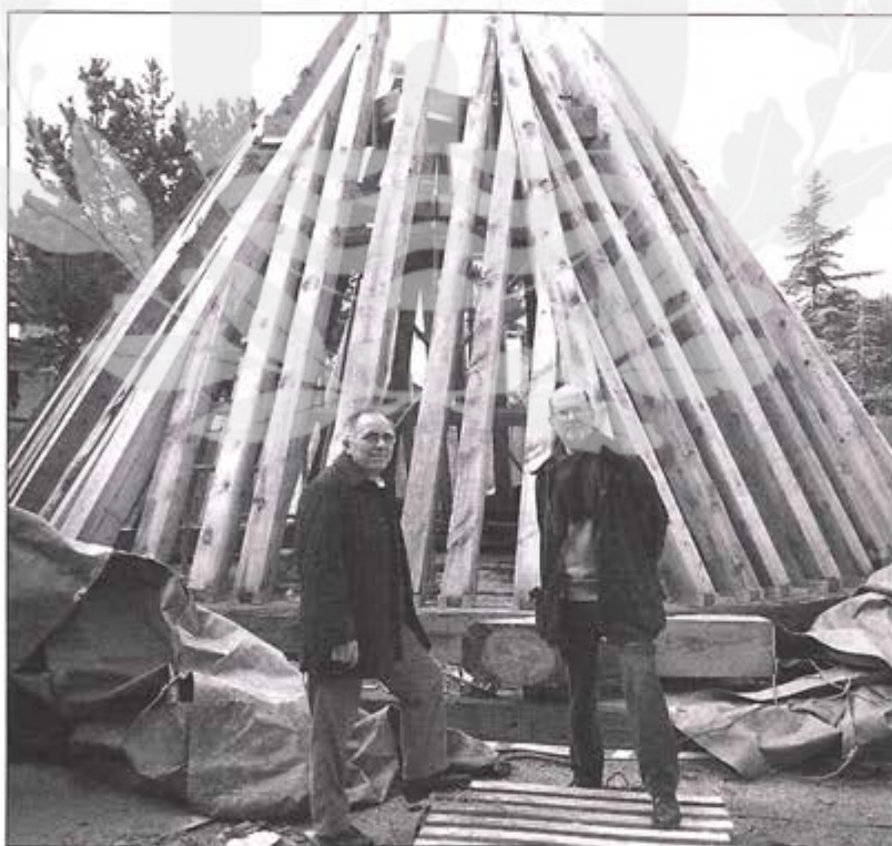
Ángel Pérez y Arsenio Lope, junto a una estructura de madera destinada a la cúpula (Foto: Archivo PM)
