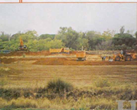
Máquinas moviendo tierras.
