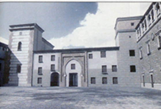
Fachada occidental del Patio de Armas
