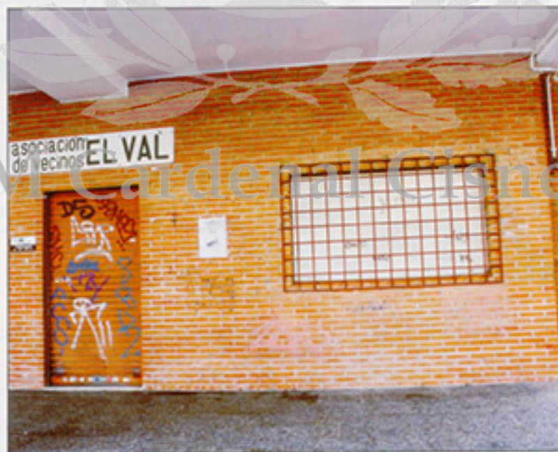
Sede de la AVV El Val, en la avenida de Castilla.
