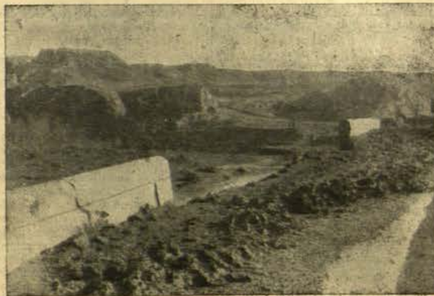
Otro aspecto del puente del Zulema después del siniestro. (Foto Dreyer.)
