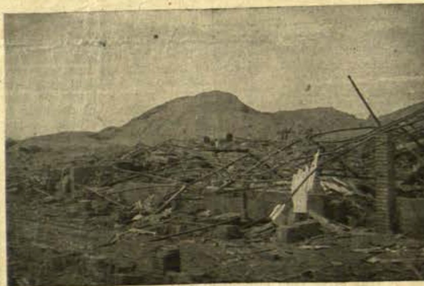
Otro aspecto de las ruinas de la fábrica «Riocerámica» después de la explosión. (Foto Dreyer.)
