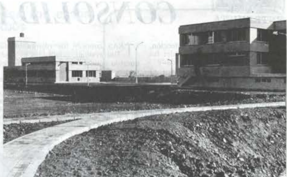
Vista general de la depuradora de Mohernando.
