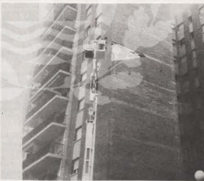
porque el material empleado para construir estos bloques no es todo lo resistente que esta instalación concretamente hubiese necesitado, el caso es que el ladrillo exterior cedió y se produjo una brecha bastante peligrosa.
