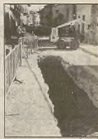
Obras en la calle Empedrado
