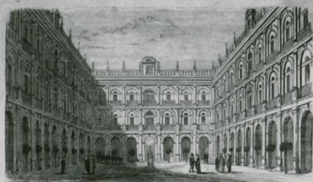
VISTA DEL PATIO PRINCIPAL.
