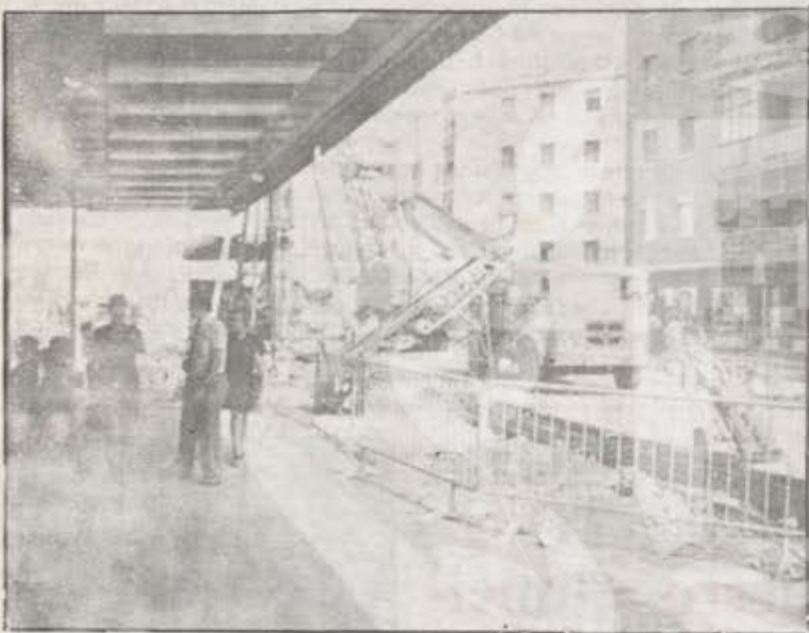
Hay también una actividad importante en el paso inferior de Torrelaguna. Se han aprobado algunos pagos complementarios en relación con las obras que se llevan a cabo. Esperemos que con este empujón la comisión de Obras saque adelante de una vez este paso, a ver si podemos olvidarnos de él.
