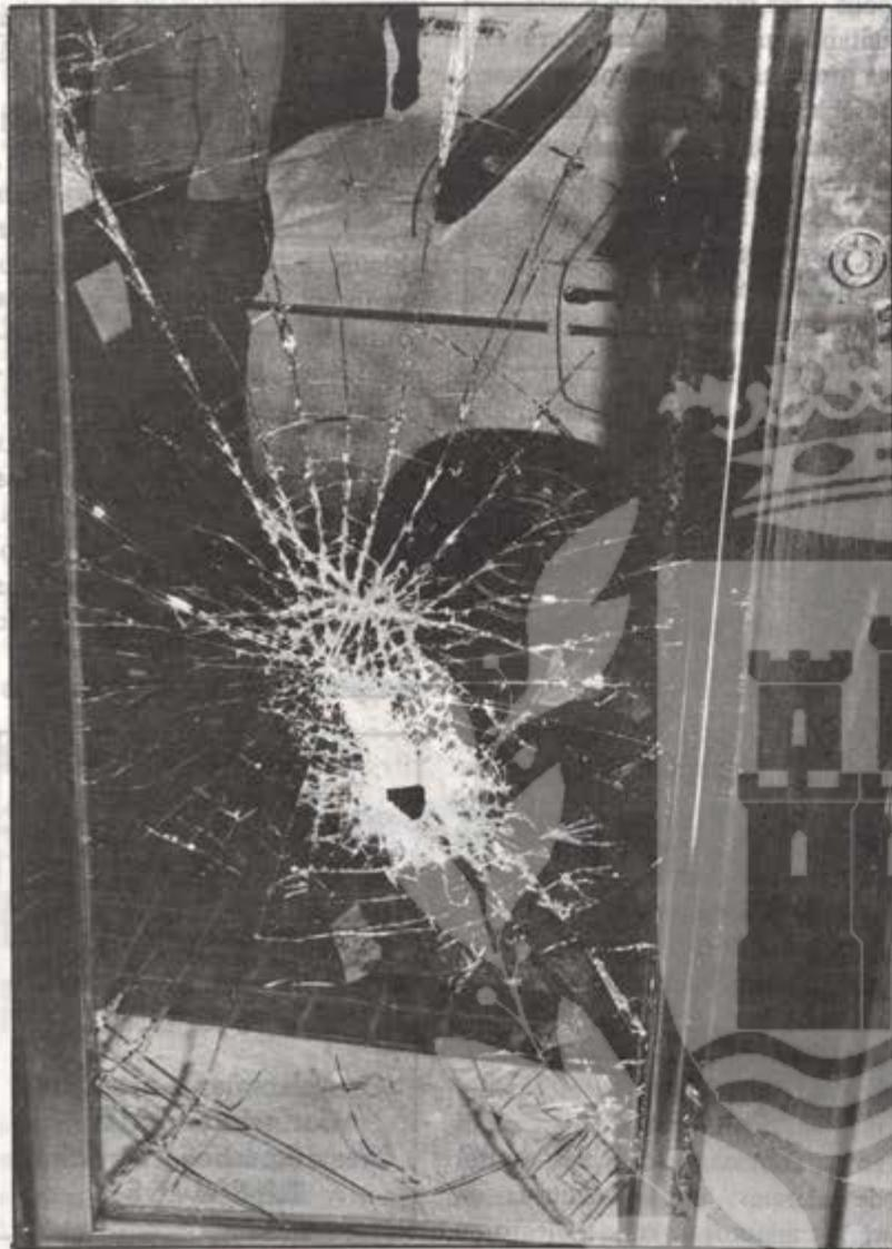
Fotografía realizada desde el interior del banco instantes después del suceso. Puede apreciarse el impacto de los proyectiles -postas- en el cristal de seguridad de la puerta del banco. En la parte superior derecha, el pulsador para abrir la puerta desde el interior.
