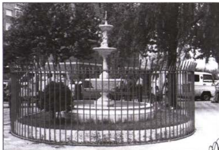
La chapuza de la fuente «presa entre rejas».
