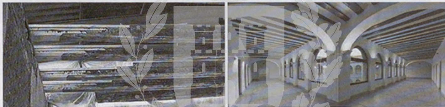
*Fotografía 11: Recuperación de vigerías de madera en el colegio del Carmen Calzado y claustro del colegio de la Trinidad Calzada con los forjados y los yesos recuperados. Fotos del autor.*
